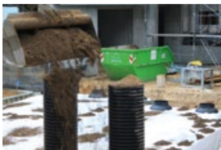
Zadanie: zabezpieczenie rury podczas zasypywania
