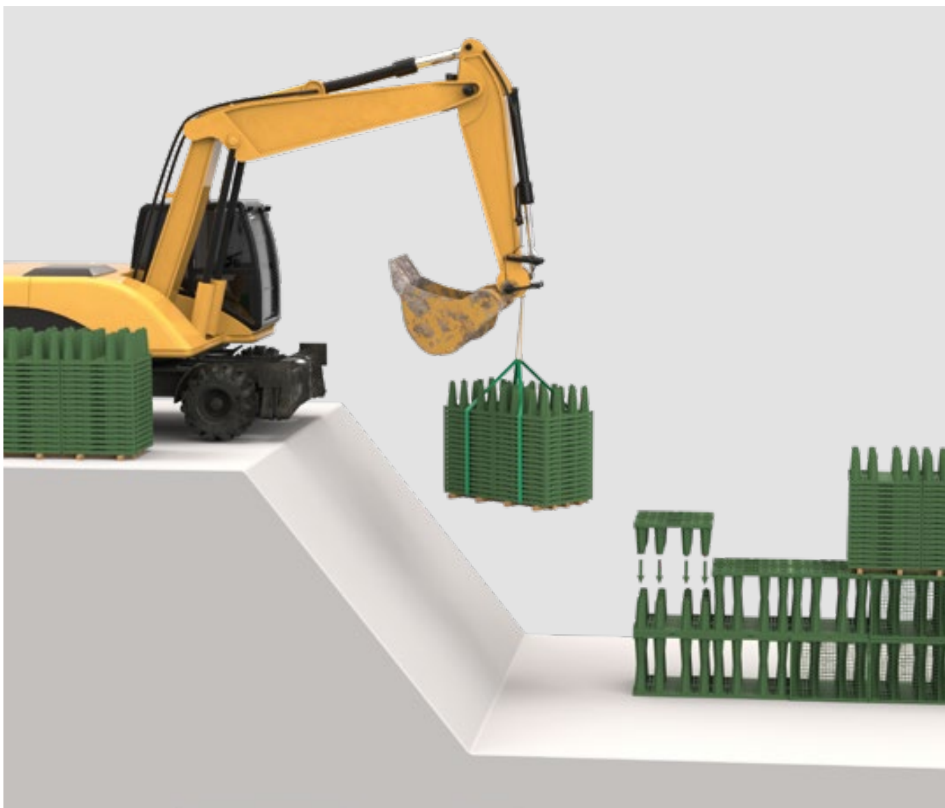
Montaż w wykopie budowlanym
